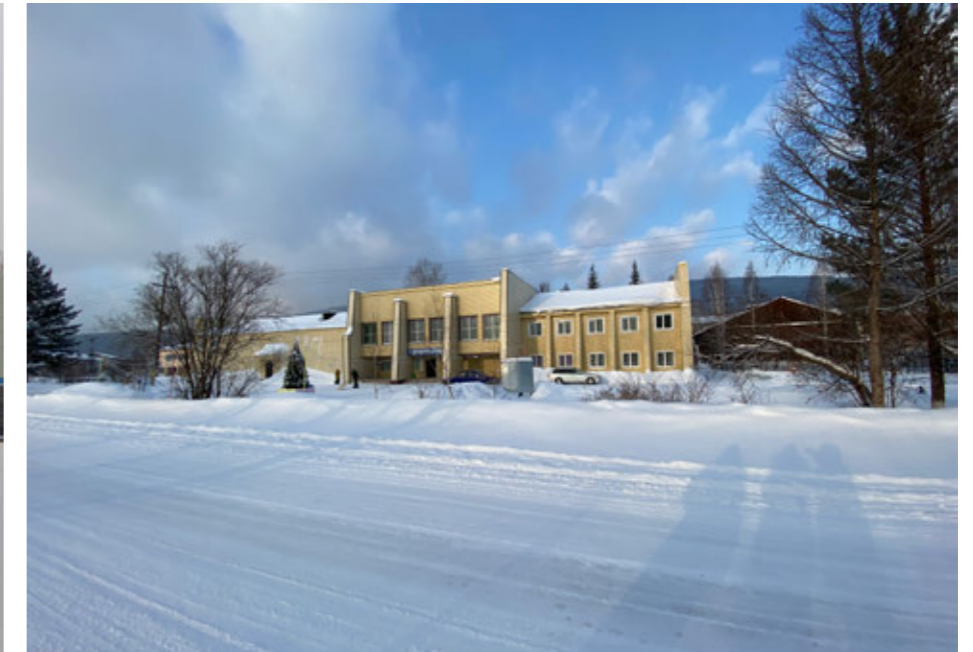
ФРАГМЕНТ 3 - Площадка в Мостоотряде
